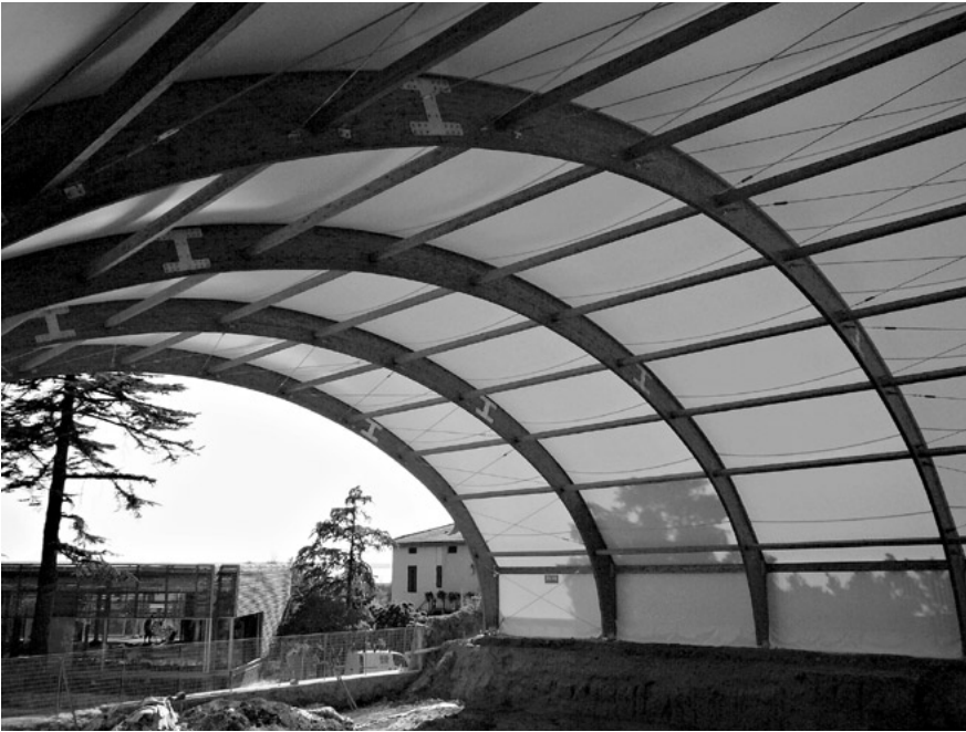
fig. 5 – Particolare della tensostruttura che copre l'area di scavo del "Cantiere".
